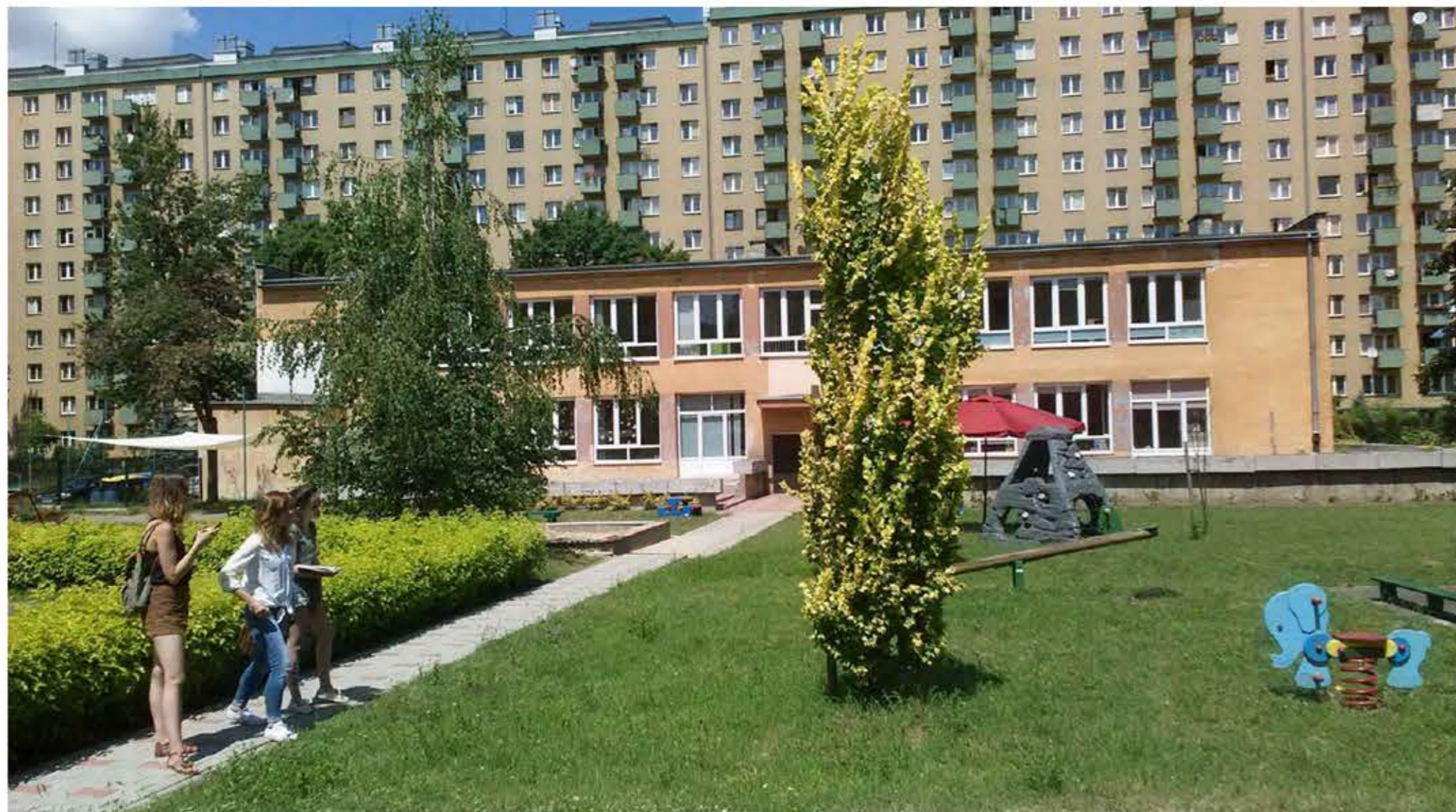
Widok na elewację południową budynku
